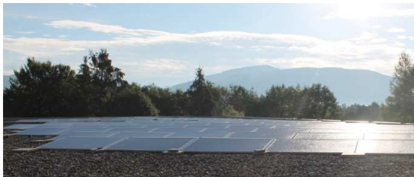
Photovoltaik-Anlage seit August 2015 in Betrieb (Werk 1)
